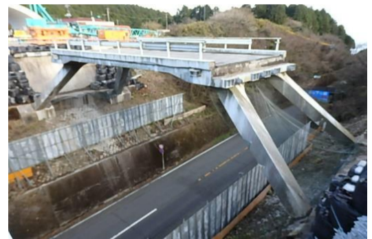
「旧十国橋解体作業」 野知 泰裕
