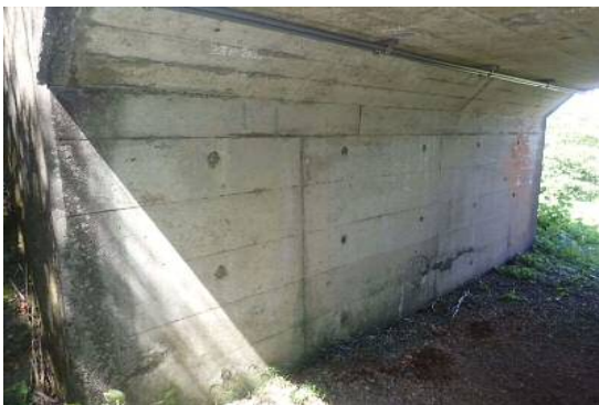
写真4 下部工(A1橋台)
