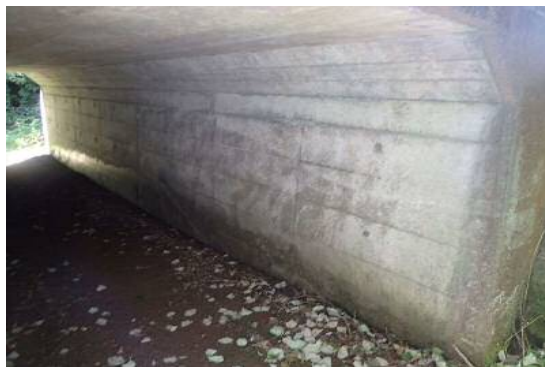
写真4 下部工(A1橋台)
