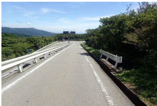
写真3 橋面(起点側から)
