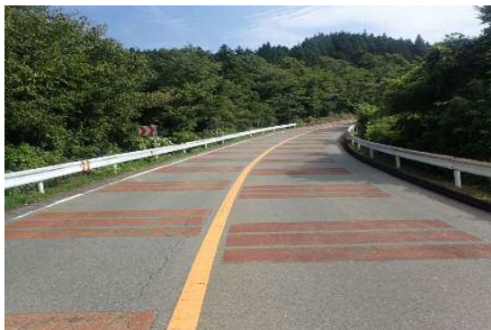
写真3 橋面(起点側から)
