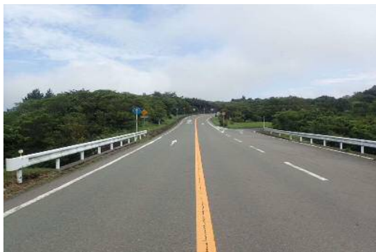
写真3 橋面(起点側から)
