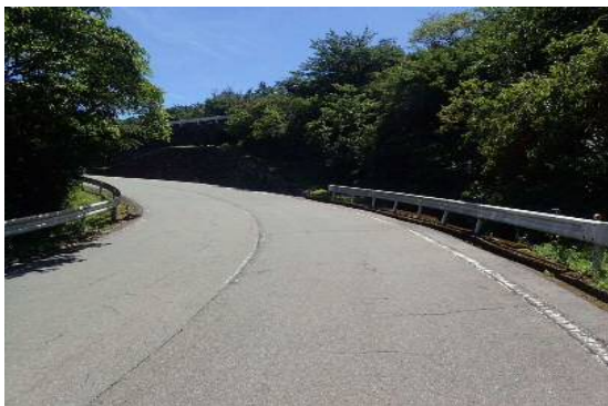
写真3 橋面(起点側から)
