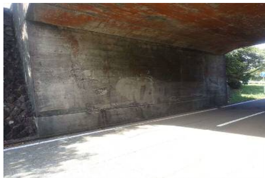
写真4 下部工(A1橋台)
