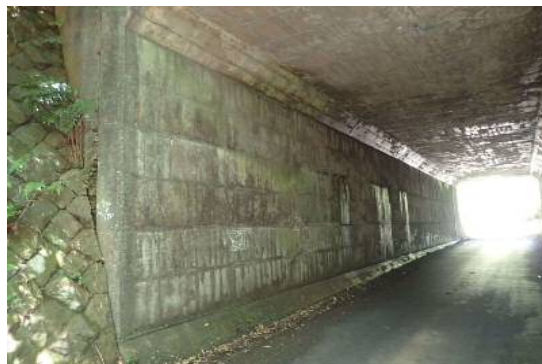
写真4 下部工(A1橋台)
