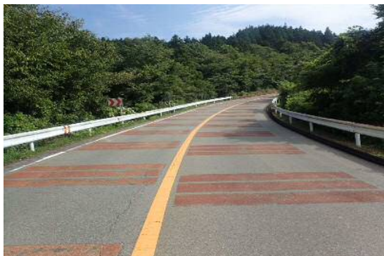
写真3 橋面(起点側から)
