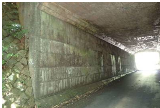
写真4 下部工(A1橋台)
