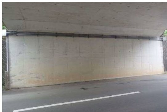
写真4 下部工(A1橋台)
