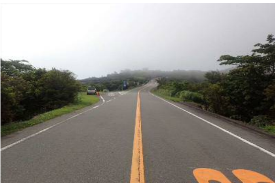
写真3 橋面(起点側から)
