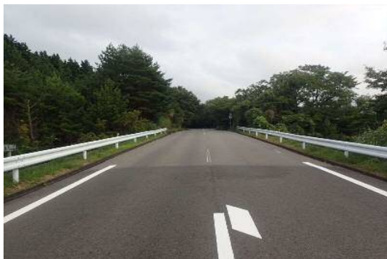
写真3 橋面(起点側から)
