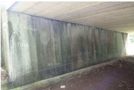
写真4 下部工(A1橋台)
